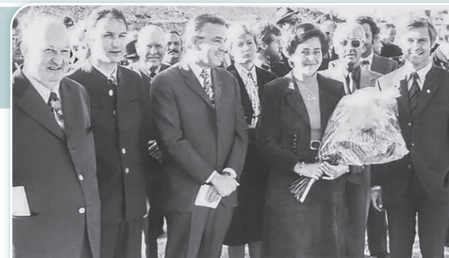
Grundsteinlegung für die Gaißacher Werkstätten am 20. Oktober 1977: Geschäftsführer Willi Löbl, Baujurist Dr. Eckart Fadinger, Gregor Dorfmeister, Schirmherrin Irmingard Streibl und Landrat Dr. Otmar Huber (v.l.)
