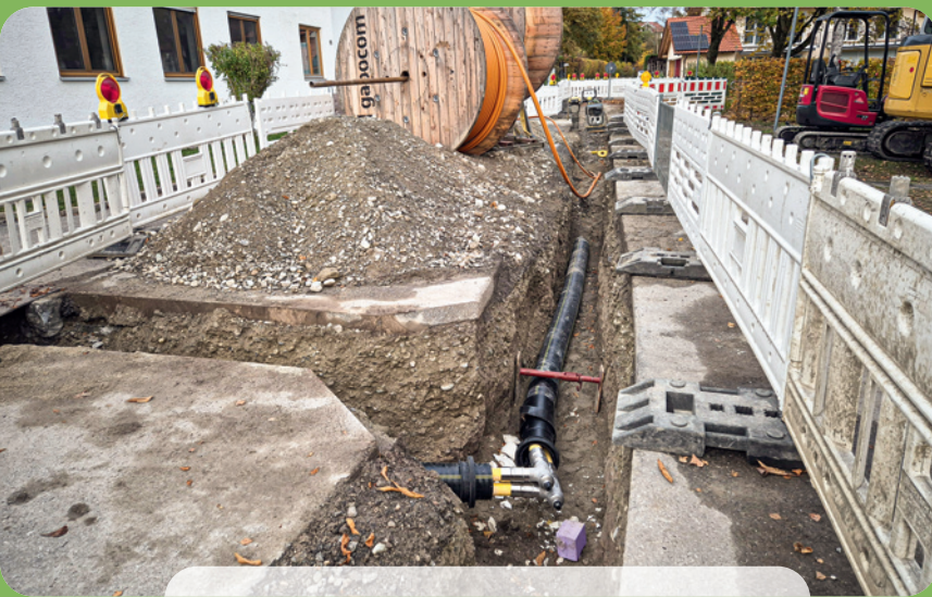
Verlegung der Fernwärmerohre zur Anbindung der Oberland Werkstätten in Polling.
